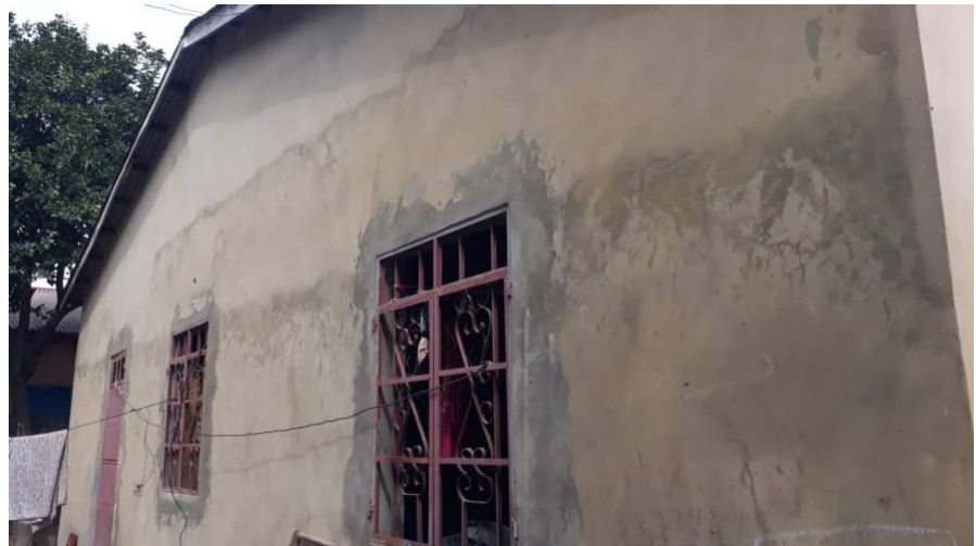
Die Fenster sind nun in das Mauerwerk eingesetzt.
